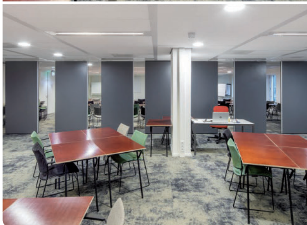
Nyenrode tijdens de verbouwfase, met tijdelijk schoolmeubilair.
