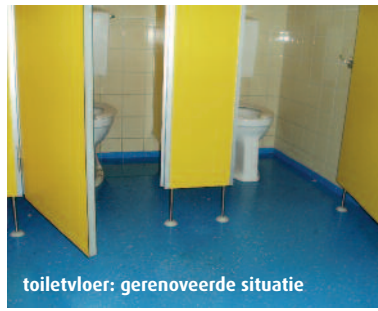
kunststofvloer met afschot in badkamer
